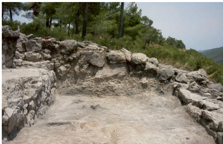
18. Bloqueo de grandes piedras construido en la parte posterior de la Puerta Sur sobre el derrumbe de tierra de la entrada (año 2002).
